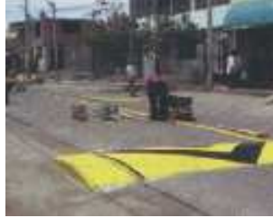
Señalización y construcción de jibas en las principales avenidas del distrito, para evitar los accidentes.
