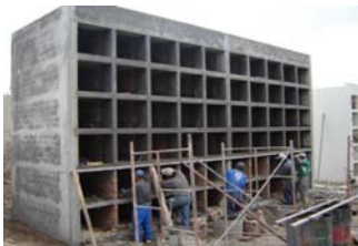
Construcción de nichos en el cementerio San Hilarión.
