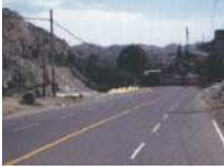
La Av. Tahuaytinsuyo y las vías de acceso a los AA.HH. La Merced y Loma Verde fueron asfaltados.
