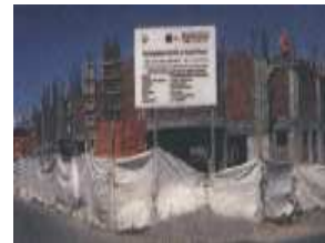
Construcción de la casa del deporte y de la juventud, edificación que se realiza en convenio con SENCICO.
